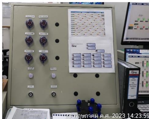
ภาพที่ 2.2-47 ระบบสัญญาณเตือนอันตราย
