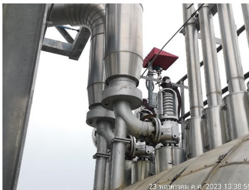
ภาพที่ 2.2-42 ลิ้นนิรภัย (Safety Valve) ที่ท่อ steam ของหม้อน้ำ
