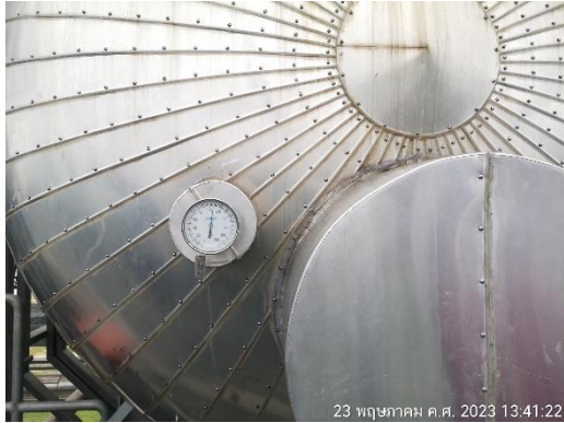
ภาพที่ 2.2-44 มาตรวัดความดันไอน้ำที่หม้อน้ำ
