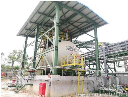
ภาพที่ 2.2-32 ถังกักเก็บแอมโมเนียมไฮดรอกไซด์เหลว
