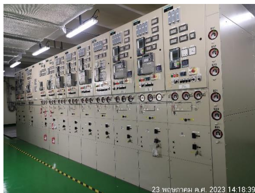
ภาพที่ 2.2-46 ระบบป้องกันทางไฟฟ้า (Relay) ที่เครื่องกำเนิดไฟฟ้า และหม้อแปลงไฟฟ้า
