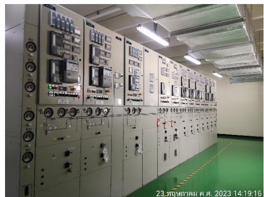
ภาพที่ 2.2-46 ระบบป้องกันทางไฟฟ้า (Relay) ที่เครื่องกำเนิดไฟฟ้า และหม้อแปลงไฟฟ้า
