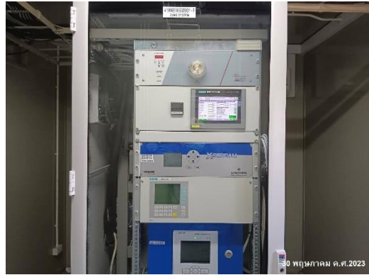
ภาพที่ 2.2-2 ระบบ CEMS จากปล่อง HRSGs 1
