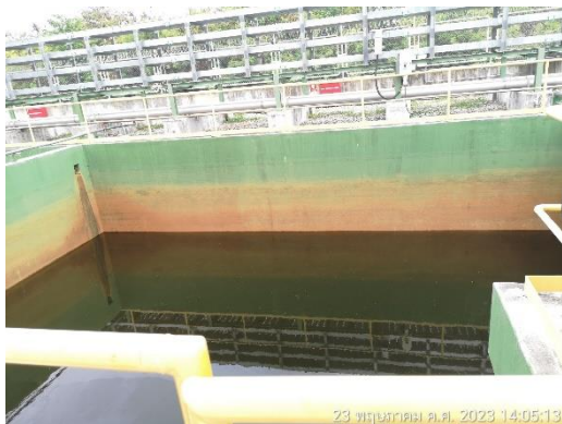
ภาพที่ 2.2-9 บ่อพักน้ำทิ้ง ขนาด 320 ลูกบาศก์เมตร
