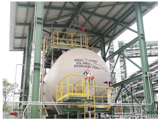
ภาพที่ 2.2-32 ถังกักเก็บแอมโมเนียมไฮดรอกไซด์เหลว
