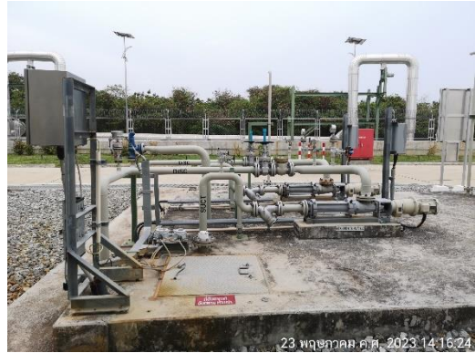
ภาพที่ 2.2-6 ระบบรวบรวมน้ำที่อาจปนเปื้อนน้ำมัน
