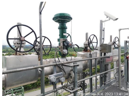
ภาพที่ 2.2-37 Shut-off Valve บริเวณ Connection
