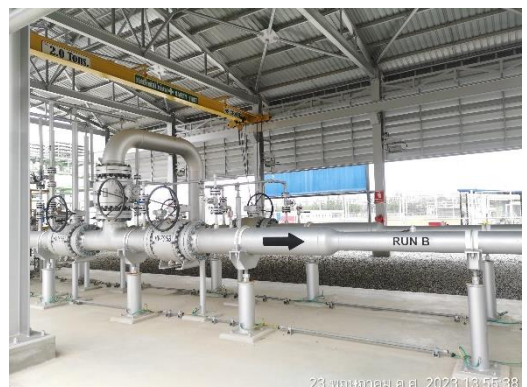
ภาพที่ 2.2-39 ระบบท่อและระบบวาล์วสำรอง
