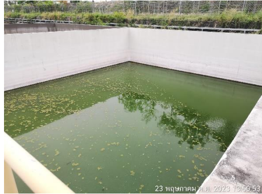
ภาพที่ 2.2-12 บ่อพักน้ำฉุกเฉินขนาด 1,800 ลูกบาศก์เมตร
